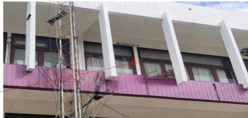
๔. งานปรับปรุงซ่อมแซมบันไดทางขึ้นชั้นดาดฟ้า ก่อนทำ
