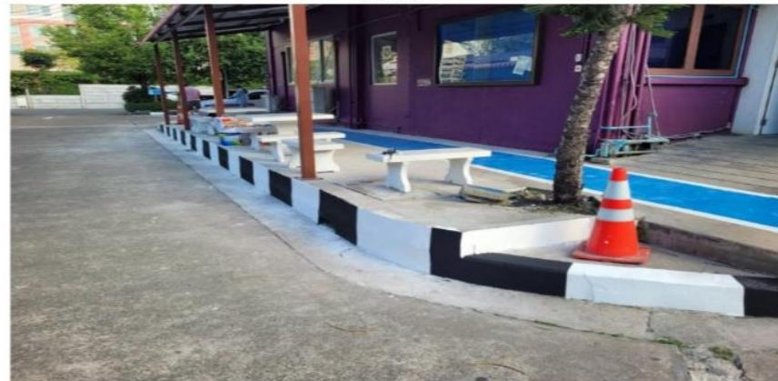
๒. งานลูกกรงเหล็กกันตกสำหรับประชาชน ก่อนทำ
